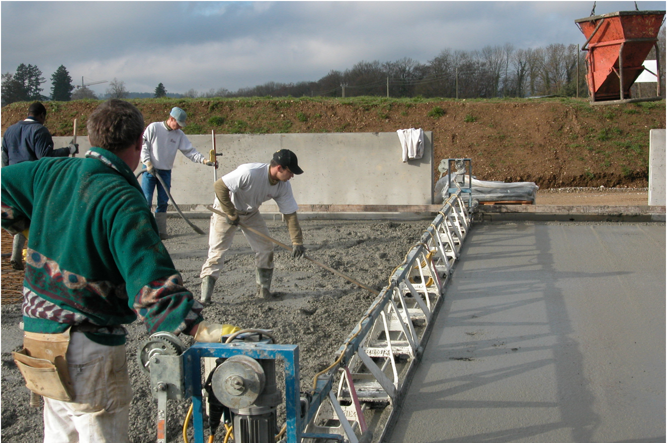
Guss einer Bodenplatte für den allerersten Bau mit Pneumatit 2006-07: einen Laufstall in Rheinau. (Foto: Gut Rheinau AG)
